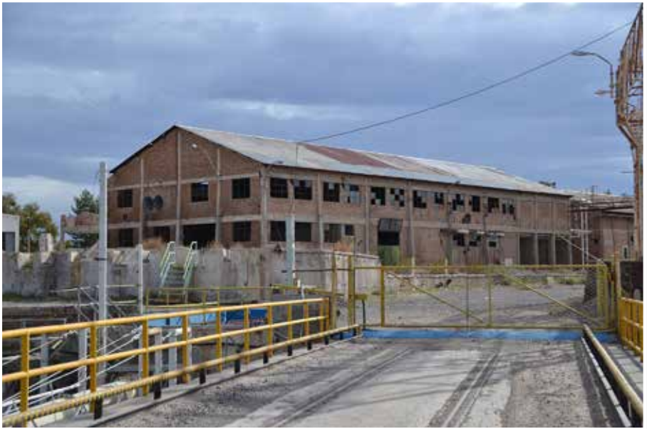
Planta abandonada de la ex INDUPA, en la ciudad de Cinco Saltos. Allí residen los restos de la peor contaminación de la historia de la zona. | Fotógrafo: Alexis Vichich
